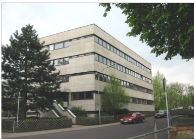
vor der Betonsanierung
