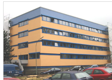
nach Betonsanierung, Fassade mit WDVS
